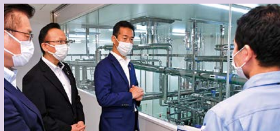
国産ワクチン・治療薬の研究開発を行っている企業の設備などを視察する岡本衆院議員ら＝2021年9月 都内
