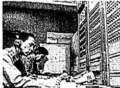
機械化初期の管制室
